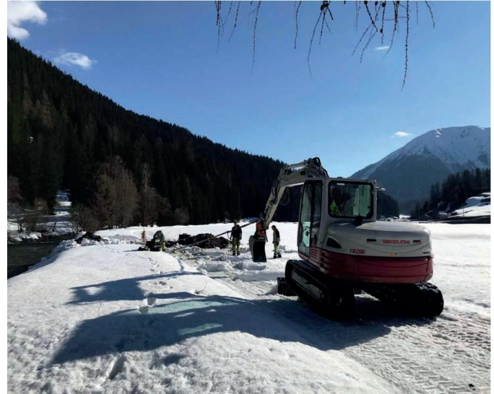
Erneuerung Mittelspannungskabel beim Kraftwerk Frauenkirch.
