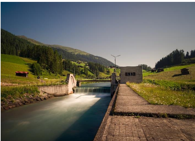
Die Wasserfassung des Wasserkraftwerkes Glaris; eines der beiden Wasserkraftwerke der EWD AG
