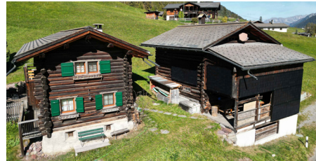
Davos Glaris, Winterstromanlage an Fassade
