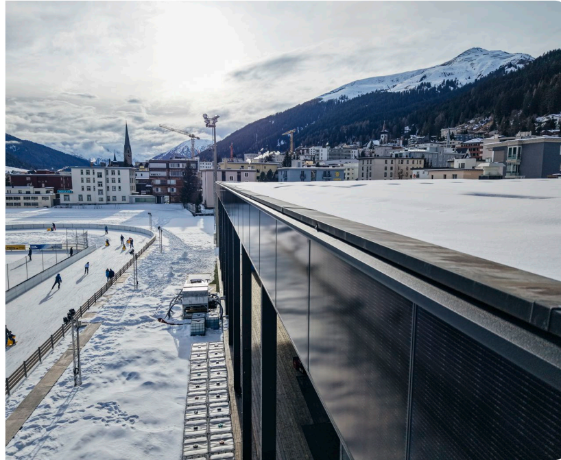
HCD-Trainingshalle Davos Platz, EWD Solar PV-Fassadenanlage für Winterproduktion.
