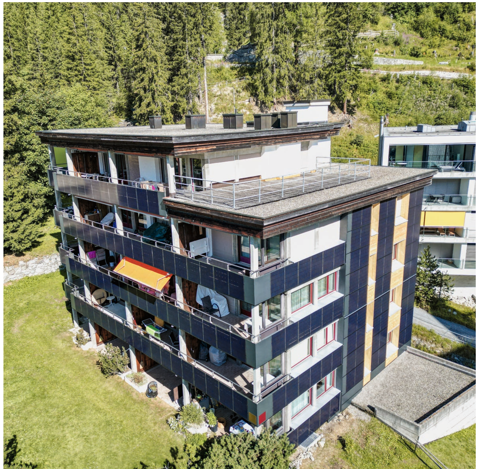
Davos Platz, BIPV (Gebäudeintegrierte Photovoltaik)
